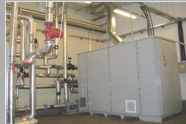
Générateur électrique / Electric generator
